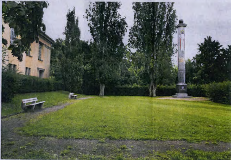
Sanierungsfall: Das von Lena von Schauroth entworfene Ehrenmal in Oberursel
